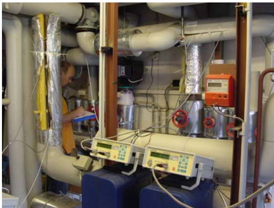
Messung in einer Wärmeübergabestation
