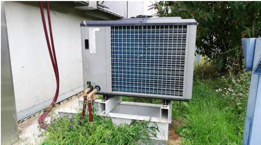
Abbildung 4-3: Foto der Außeneinheit des Kältesystems mit Sensorik
