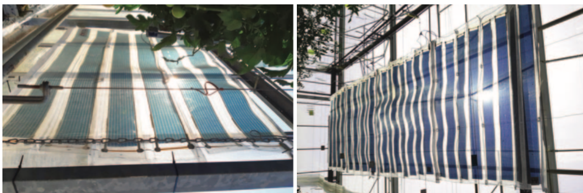
Abbildung 47: Verschiedene Anwendungsmöglichkeiten von OPV beispielsweise an Gewächshäusern (Vandest und Hemetsberger 2021).
