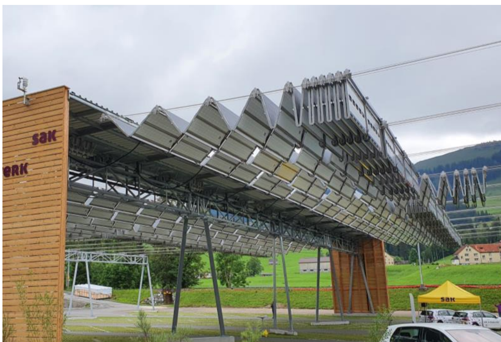
Abbildung 39: Beispiel einer Faltdachanlage mit Solarmodulen, kommerziell bereits über Parkplätzen und Infrastrukturanlagen (DHP, o.J.).
