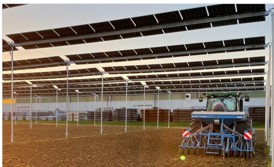
Abbildung 60: Forschungsanlage HyPERFarm - Seilaufhängung der Firma Krinner Carport GmbH (Fraunhofer ISE 2022c).
