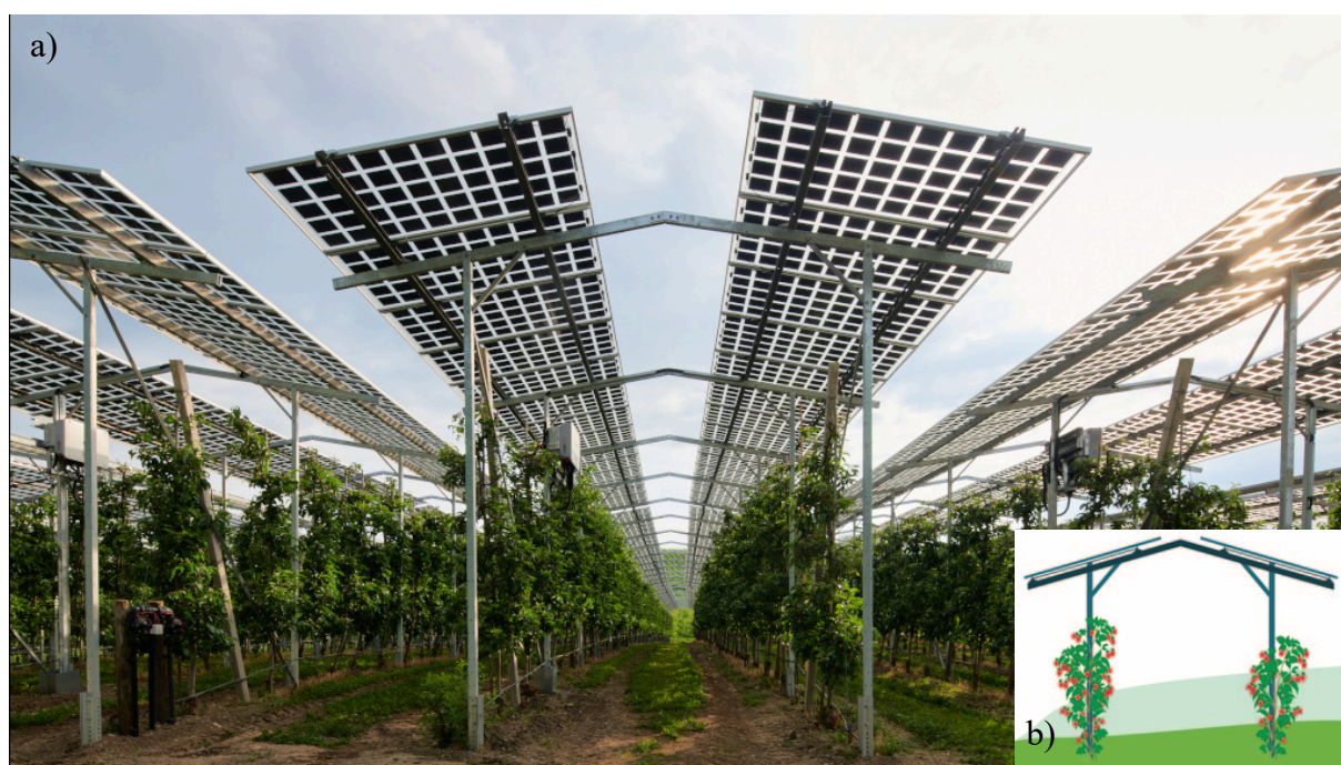
Abbildung 30: a) APV-Anlage in Kressbronn (BW) mit Sonderkultur Apfel, wobei Teile der Aufständerung als Leithilfen verwendet werden ©BerndSchumacher (Gentner 2022) und b) Schematische Darstellung der Rankhilfe (Vandest und Hemetsberger 2021).
