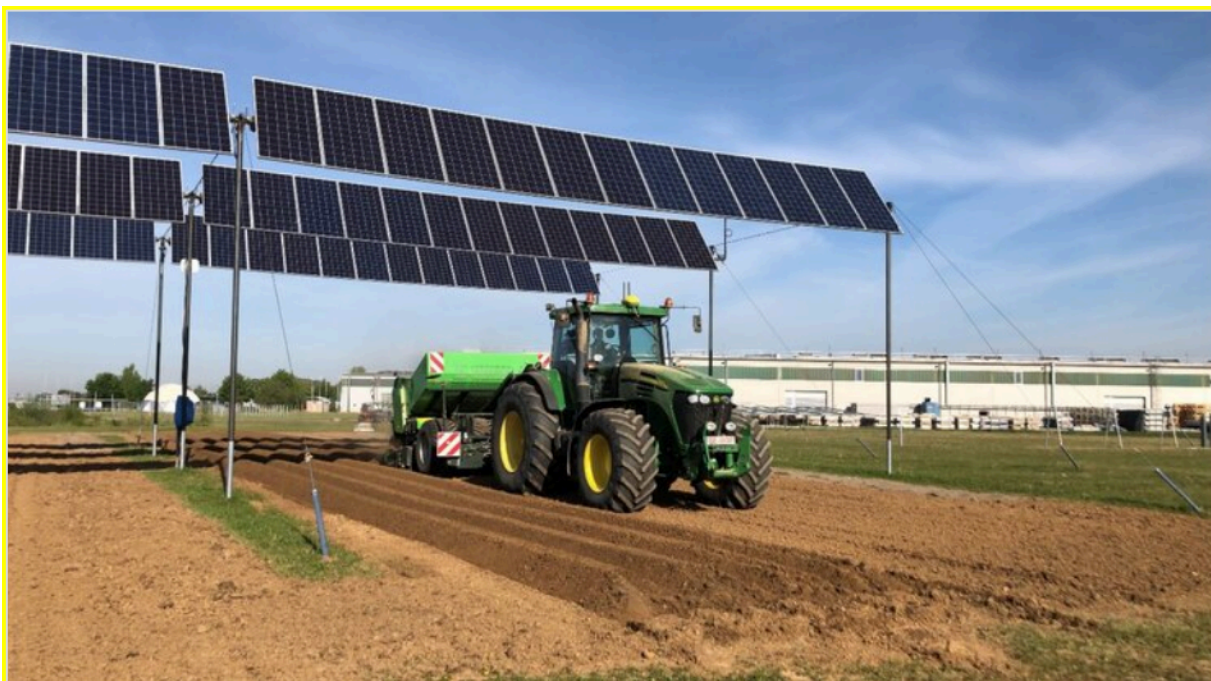
Abbildung 37: Abgespannte Seilaufhängung einer APV-Anlage in Straßkirchen, Bayern (Krinmer Carport GmbH, Harlander, 2021).
