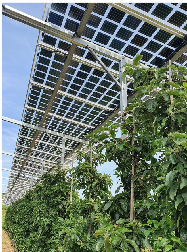
Abbildung 44: Semitransparente Module, hier als Überdachung für Äpfel in Gelsdorf (BW) (©GridParity AG 2022).
