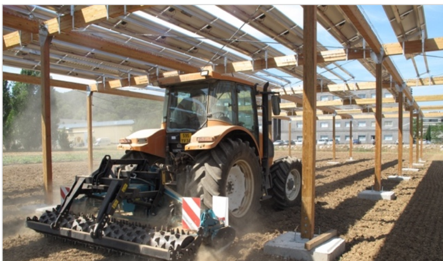
Abbildung 40: PV-Anlage mit Aufständering aus behandeltem Holz, Montpellier Frankreich (Toledo und Scognamiglio 2021).
