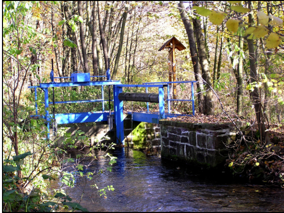
Foto 36: Teileranlage südlich Georgenthal am Abzweig des Flößgrabens (technisches Denkmal Leina-Kanal-System)
