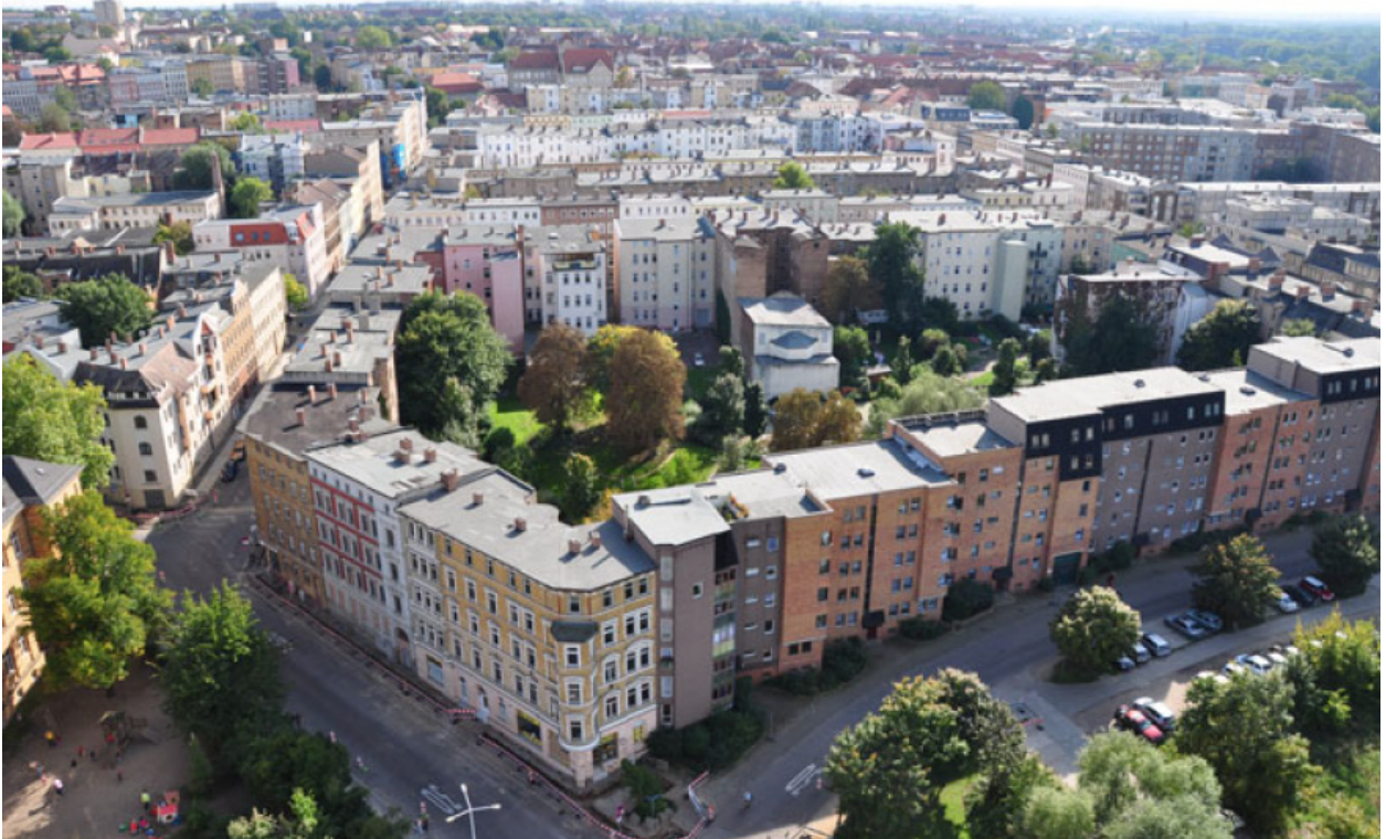
Abb. 20: Gründerzeitbebauung Halle-Glaucha (Quelle: Vollmer 2015: 147)
