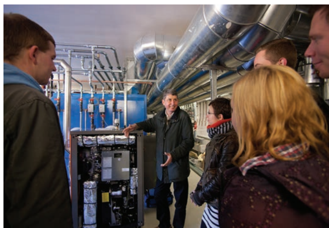
Innovative Klimatechnik im Gewächshaus
