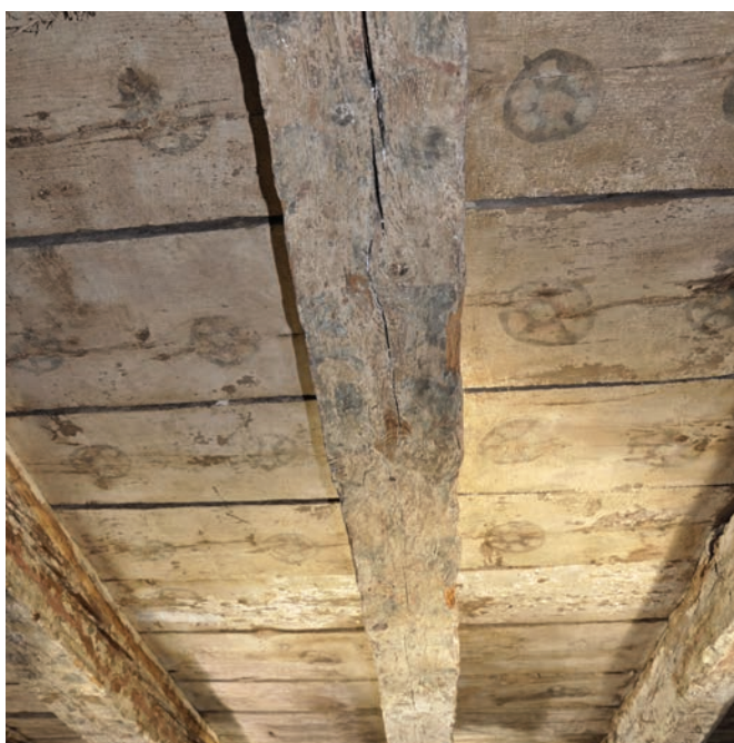
Detail der ältesten Deckenfassung im profanen Wohnraum während der Freilegung
