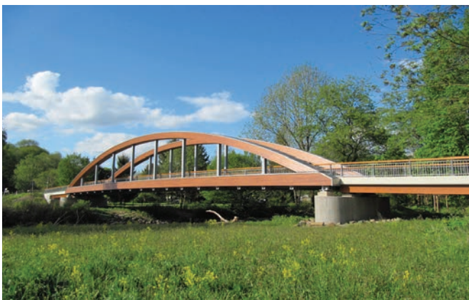
Konstruktiv geschützte Holzbrücke in Höngesberg (Foto: A. Simon)
