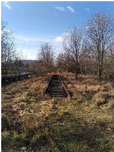
Trassenfragment in Richtung Westen
