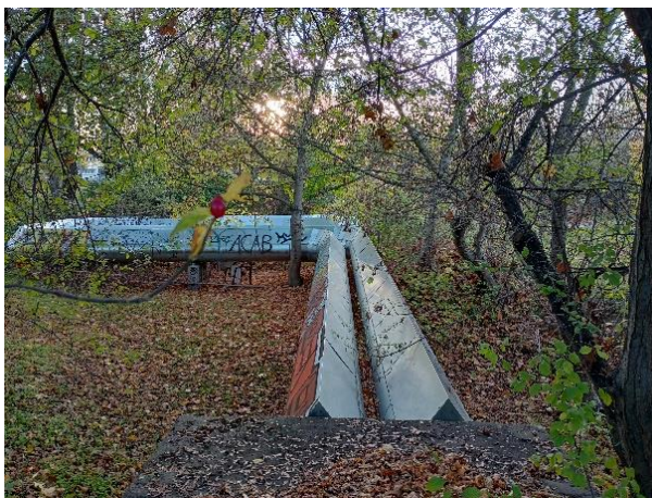
Fernleitungstrasse im Eschenbestand Fotos: E+E Team
